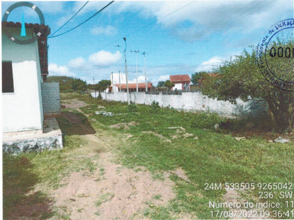
MURO LADO RUA SDO
