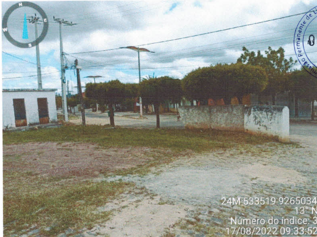
MURO ENTRADA LADO ESQUERDO
