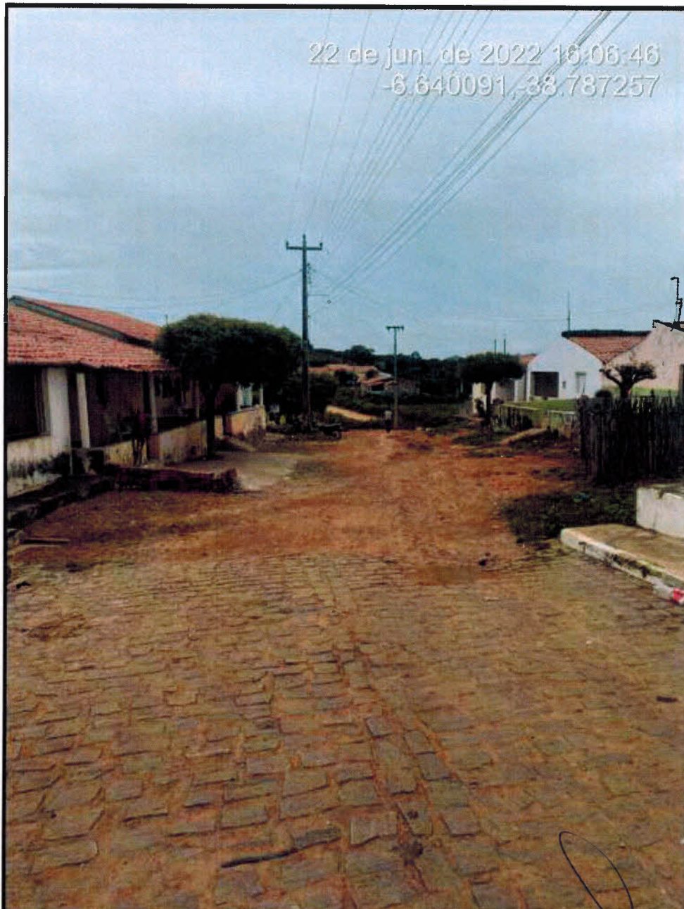
01 - INÍCIO DE PAVIMENTAÇÃO
