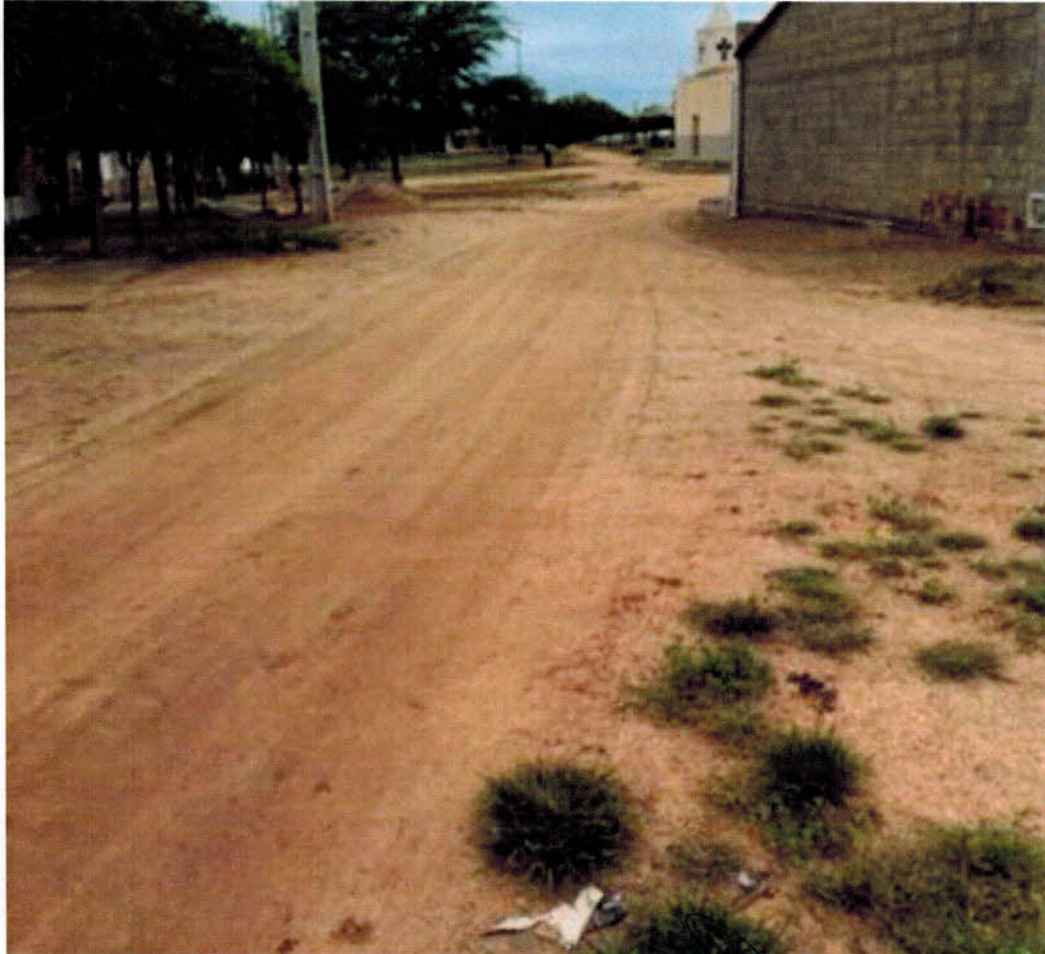
2- FINAL DE PIÇARRAMENTO
