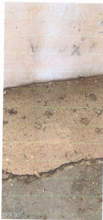
PISOS FISSURADOS
