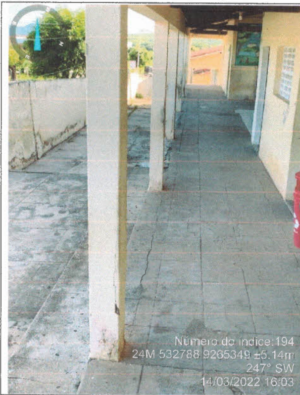
CIRCULAÇÃO PARTE INTERNA
